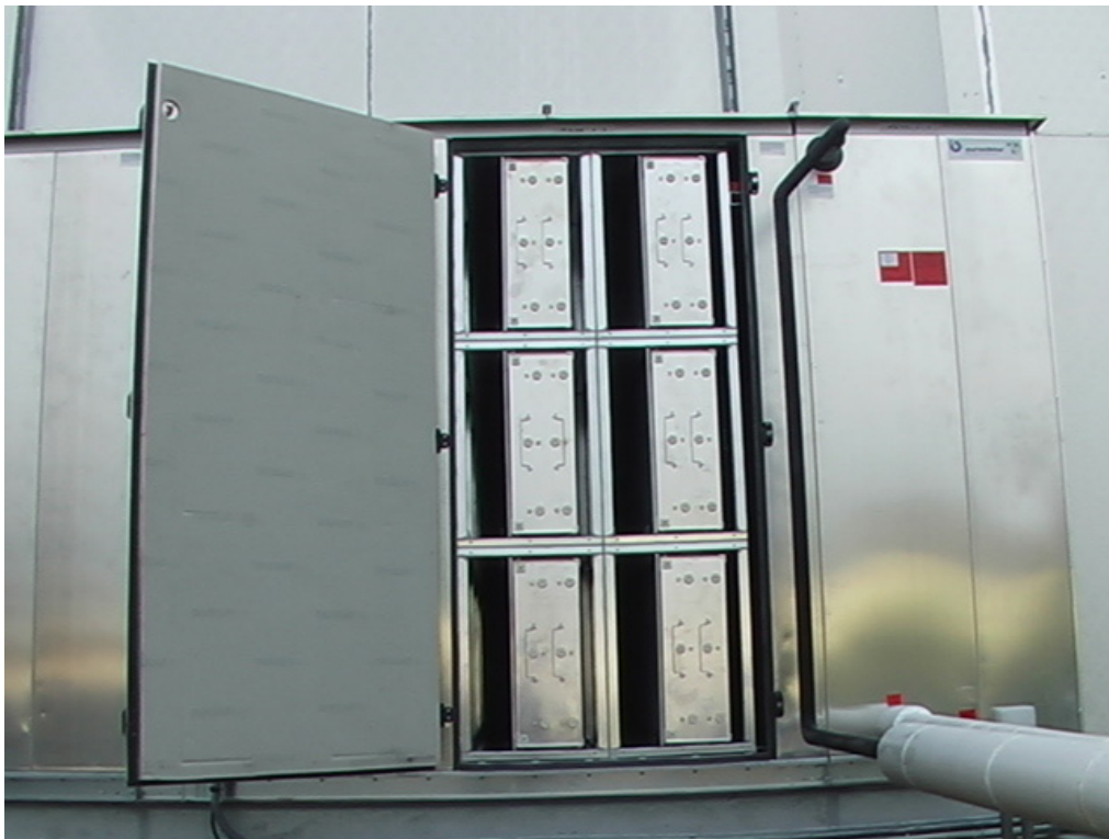
Luftbehandlingsaggregat för automatisk rengörning utrustat med elektrostatiska filter och joniseringsystem installerat i en stor multinationell företagsanläggning för livsmedelsframställning i norra Europa.
