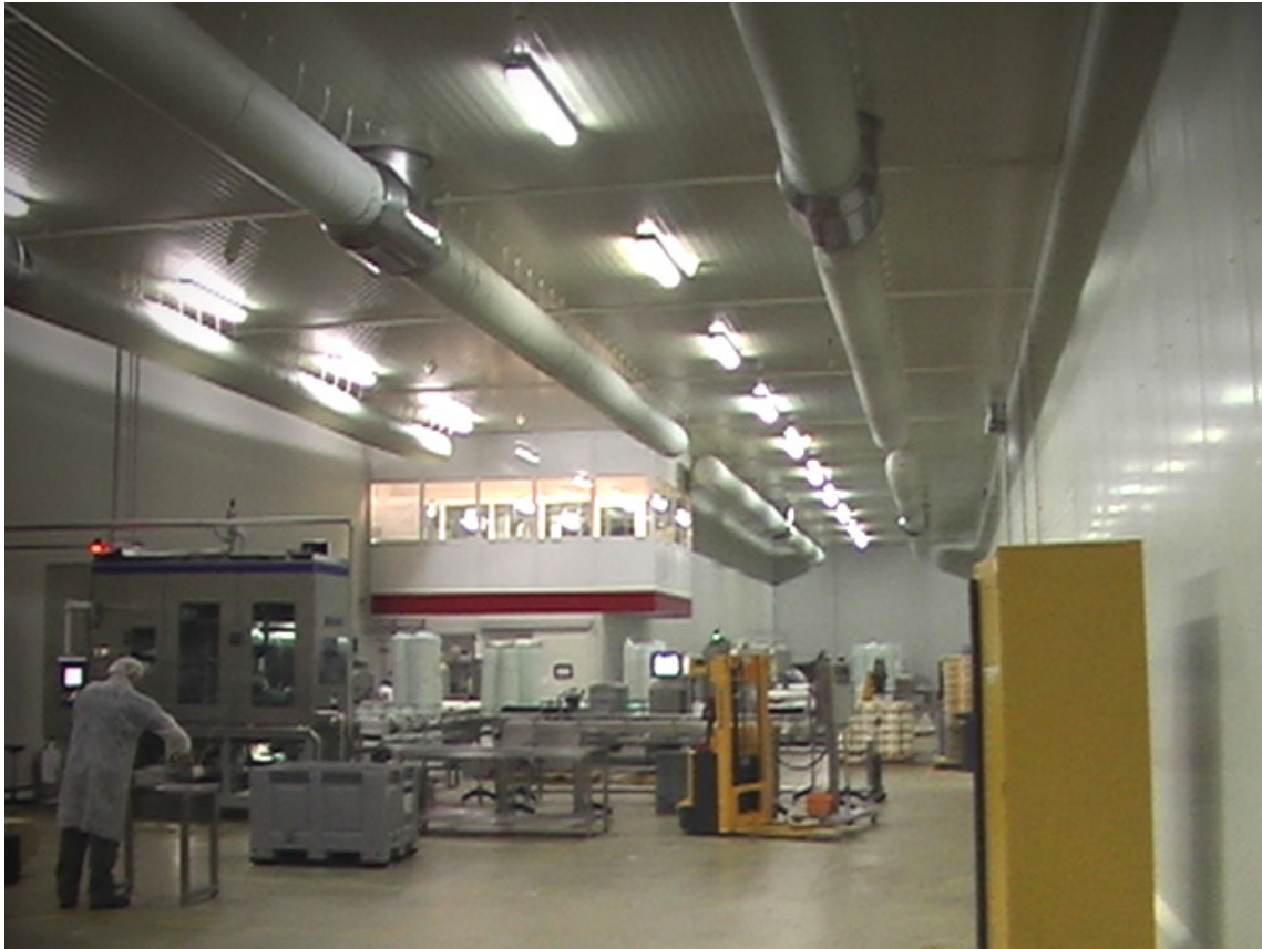
Typisk luftdistribution i ett förpackningsrum, där luften strömmar från textilkonduiter i taket och ut från ett galler alldeles ovanför golvet vid rummets fyra hörn.
