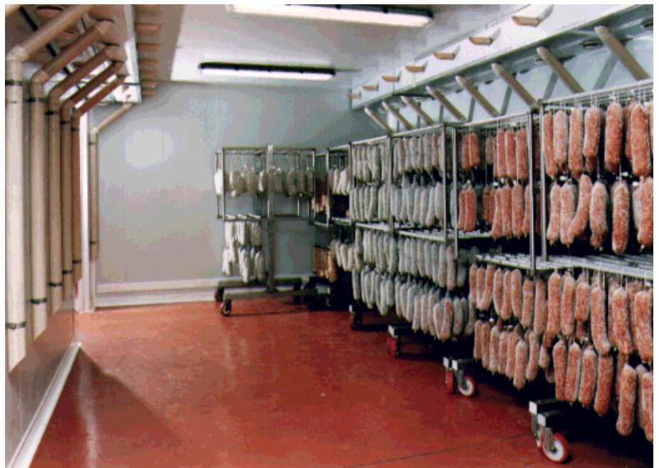
Torkrum för korv med ett speciellt svängbart luftspridningssystem.
