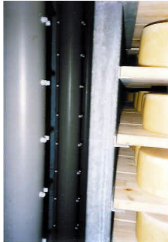
Luftfördelningsmunstycken, för att möjliggöra försiktigt luftflöde runt produkten
