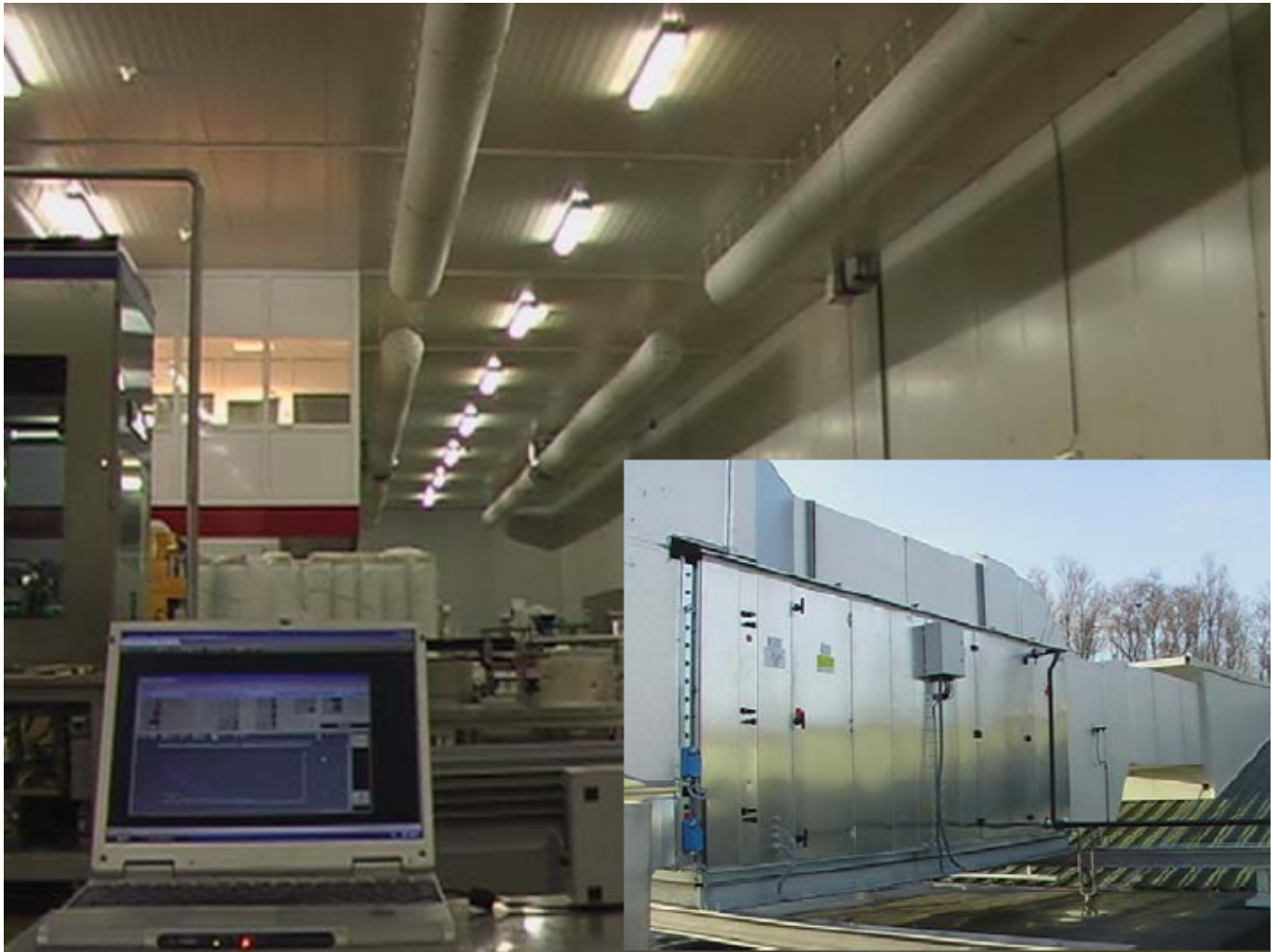
Kontamineringskontrollerat rum ISO 7 med AirClean-system
