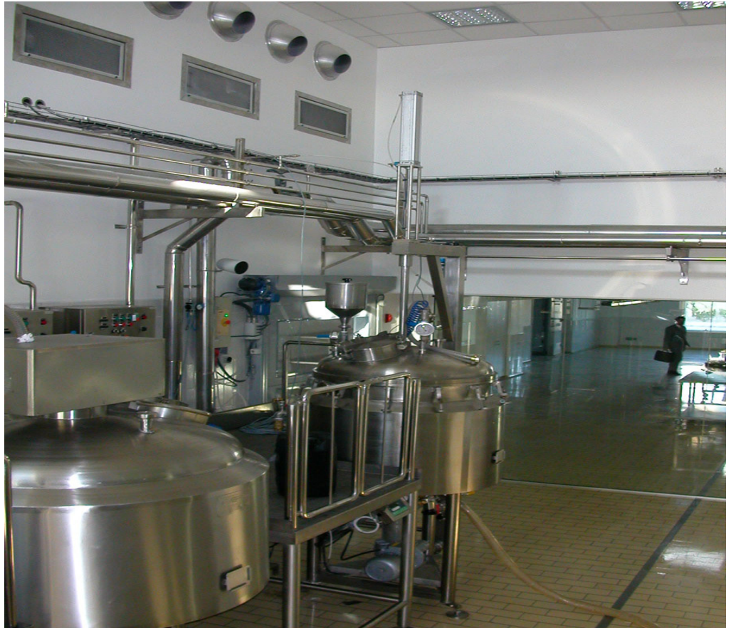
Produktionsrum för kosmetik, Rolandos Enterprises Public Ltd. byggt 2004
