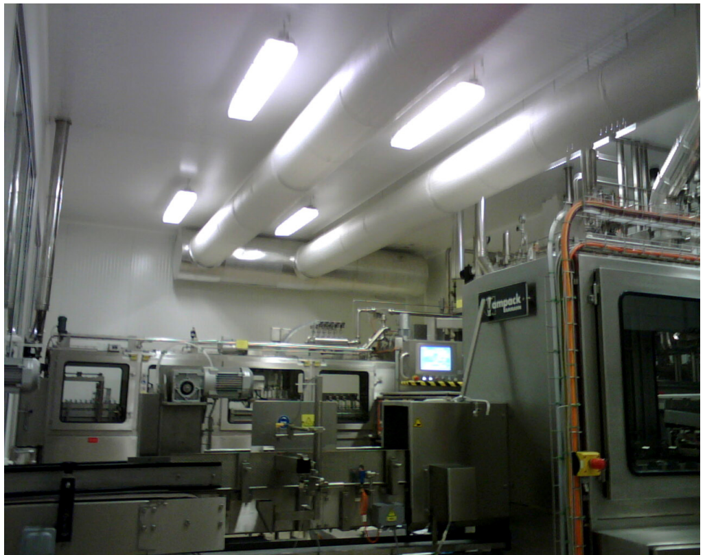
Påfyllnadsrum klass 10000 för mjölkbaserade drycker i HBC Lanitis fabrik i Nicosia, Cypern byggt 2008
