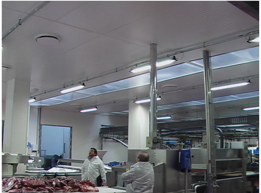
Rum för köttbehandling i Tempio di Ormelle, Itaien 2003
